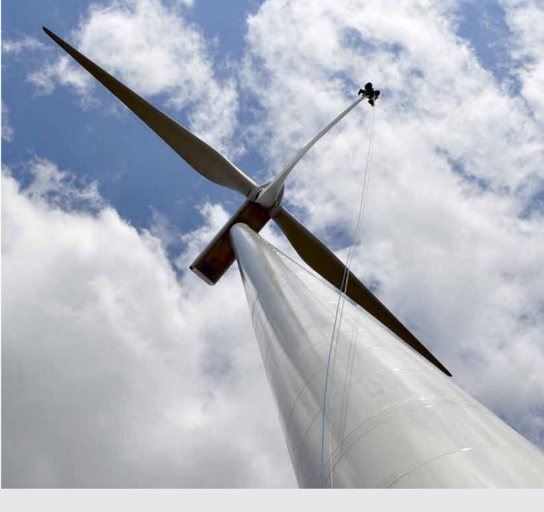
Los Sistemas de acceso con cuerdas (SACC) se adaptan con eficiencia y seguridad a los lugares de dificil acceso y espacios confinados sin necesidad de instalar andamios, estructuras, uso de grúas y afines.
